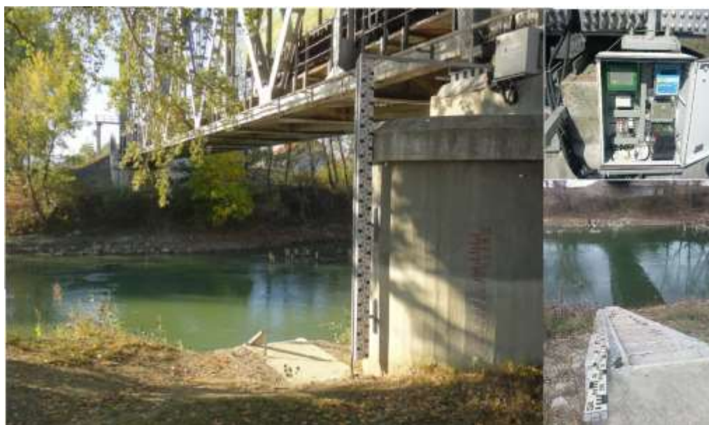
Fig. nr.5 Postul hidrologic automatizat Ungheni
